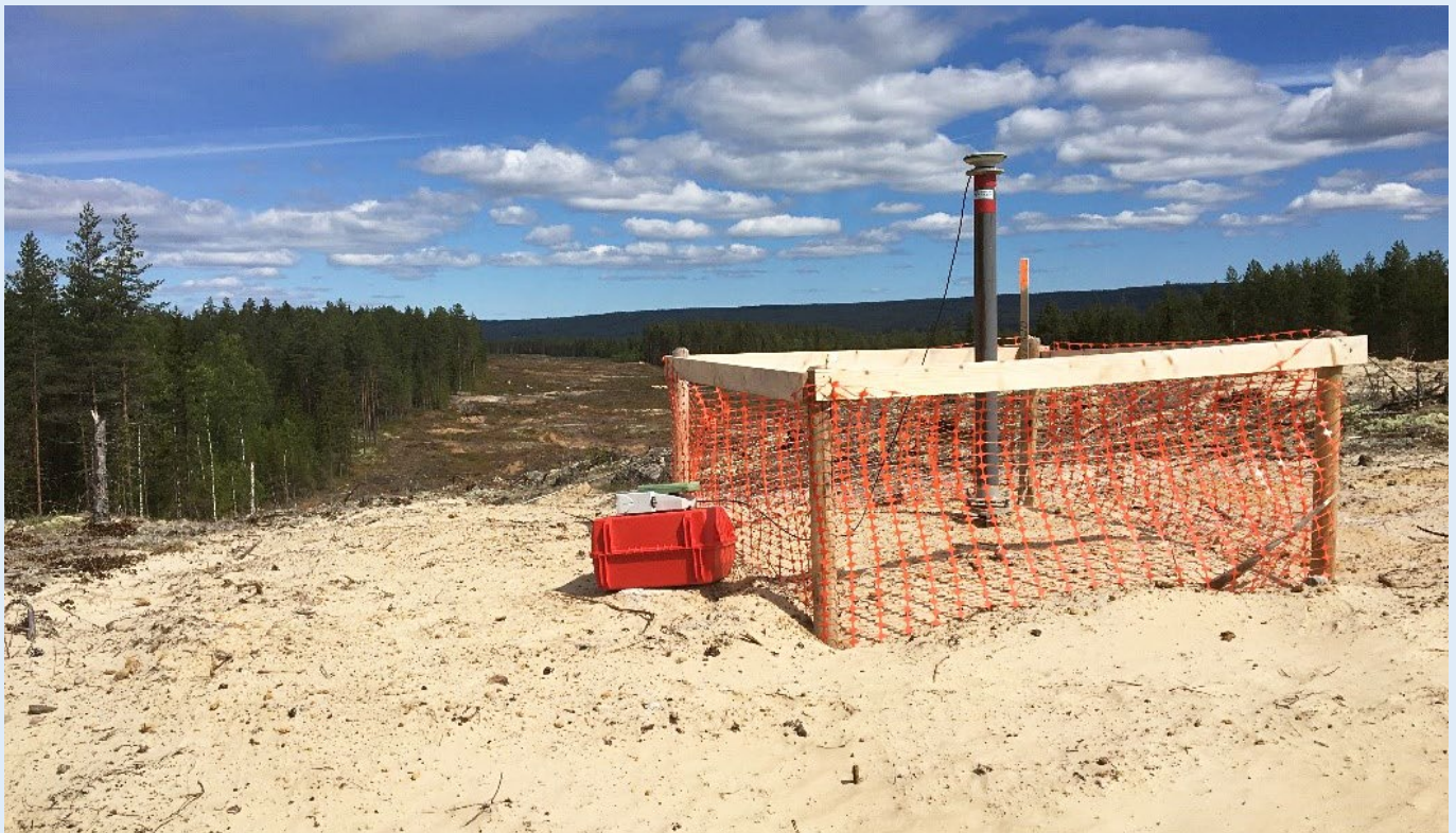
GNSS-måling av fastmerkenett på riksveg 3, nord for Elverum i 2017
